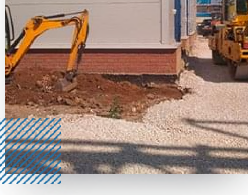
02. Укрепление фундаментов зданий
