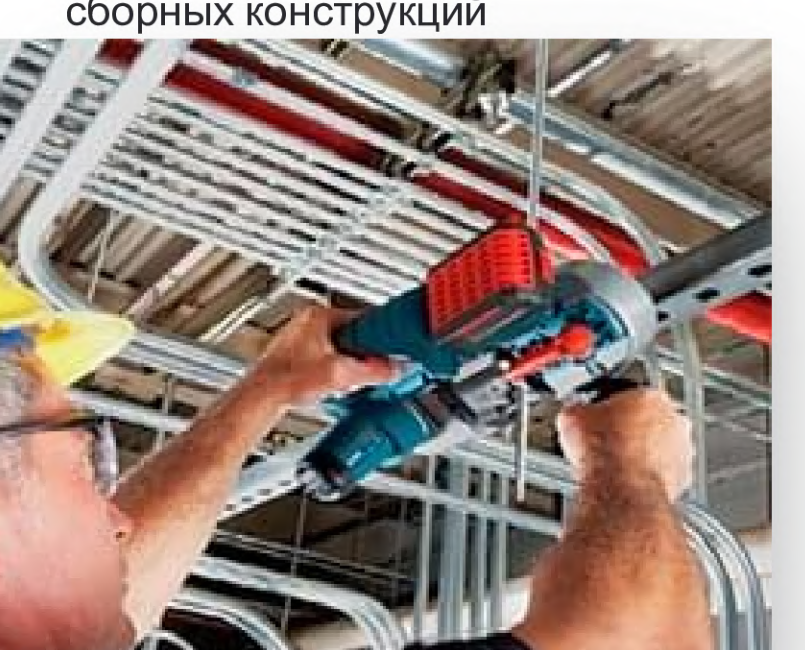
07. Производство электромонтажных работ
