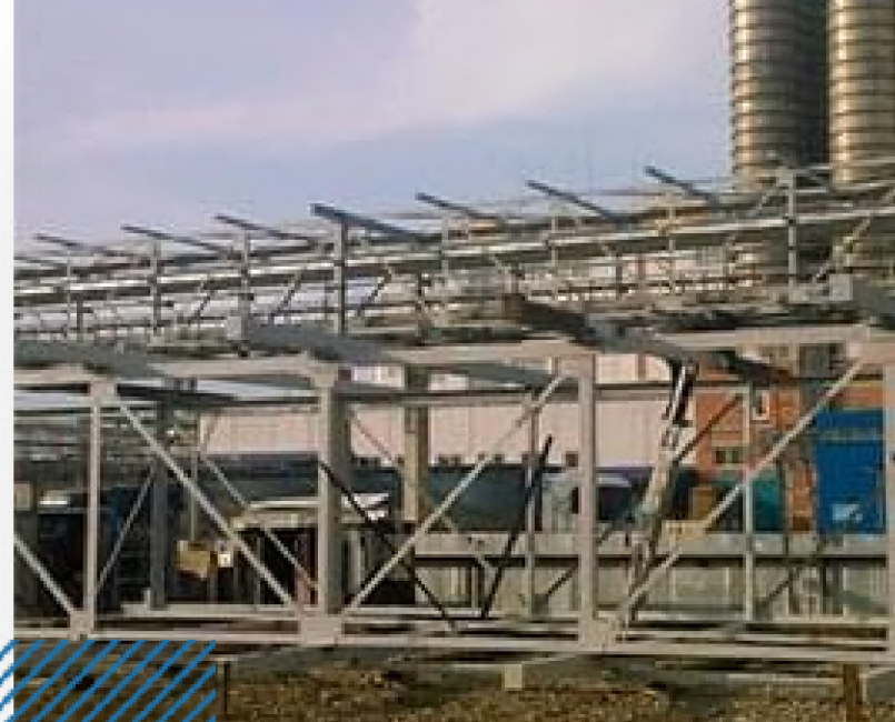
05. Монтаж зданий и сооружений из сборных конструкций
