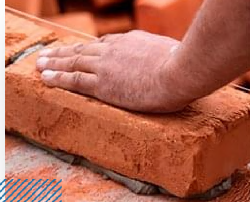
06. Работы по устройству каменных конструкций
