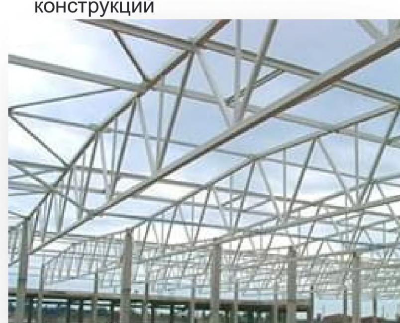
08. Монтаж металлических строительных конструкций
