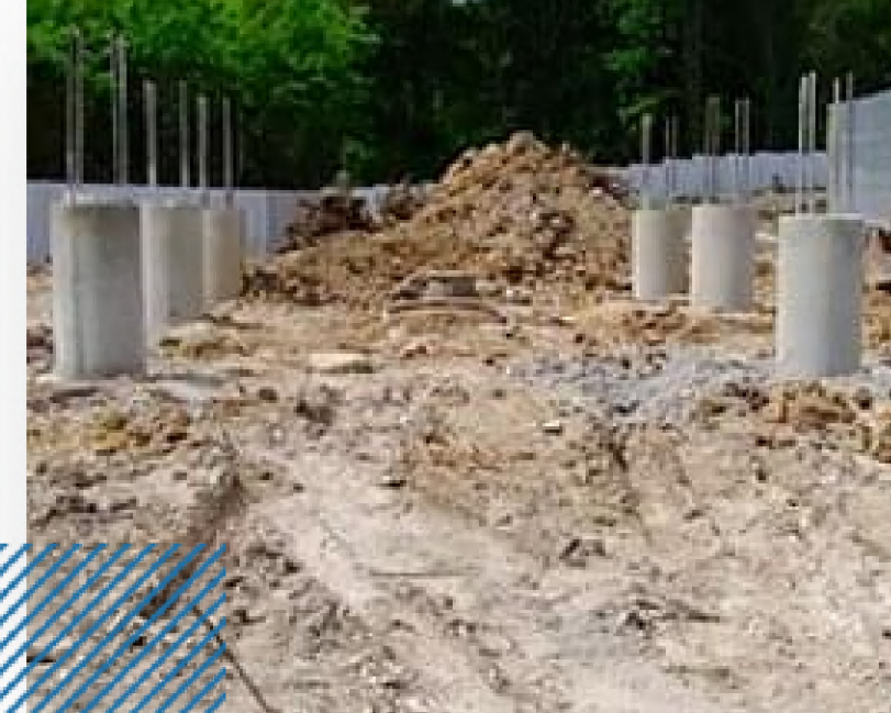
04. Устройство буронабивных свай и фундамента
