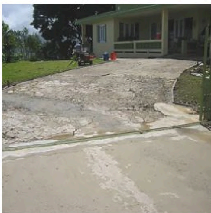
Ремонт уличных конструкций
