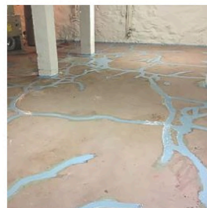
Ремонт бетонного пола
