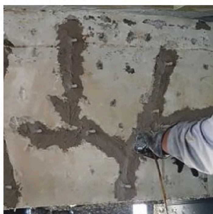
Ремонт плиты перекрытия
