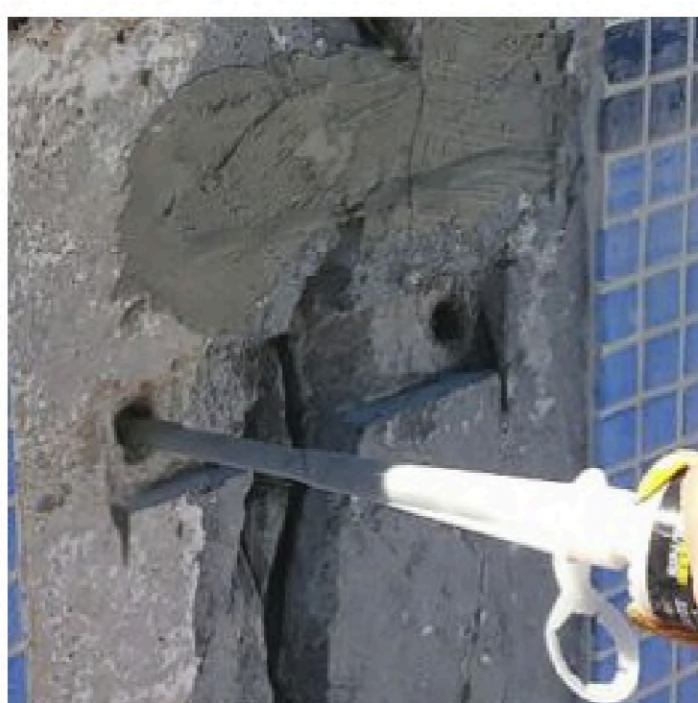
Ремонт чаши бассейна
