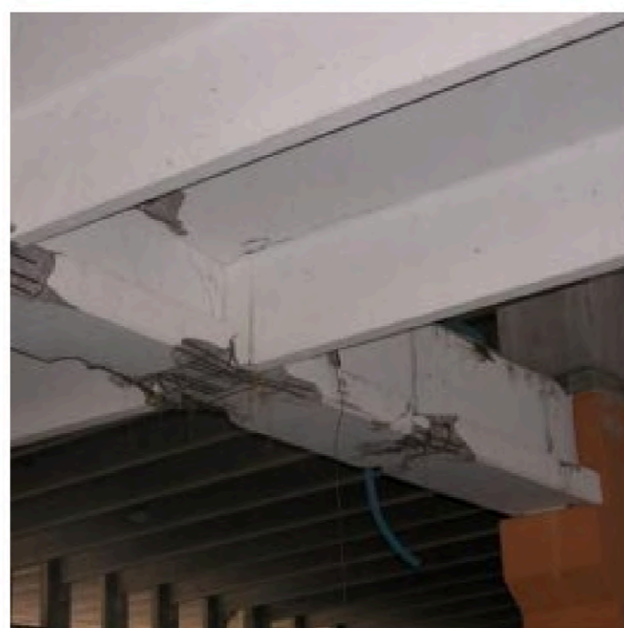
Ремонт бетонных конструкций
